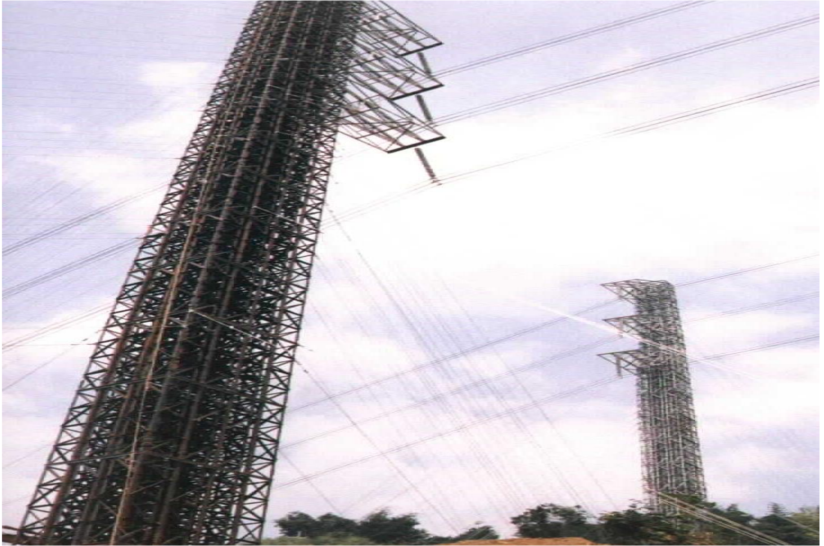
345KV 峨眉~中寮一、二路 #203搶修完成情形
