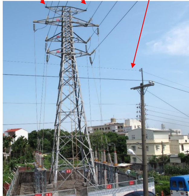
輸電 架空地線 配電 架空地線
