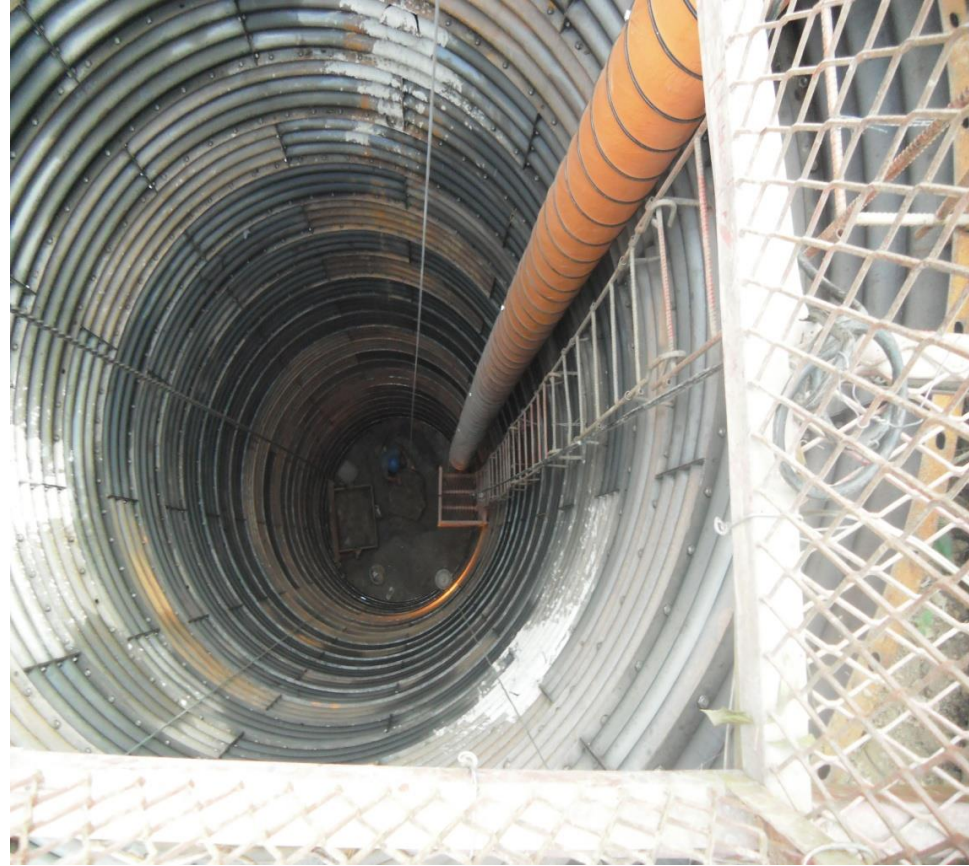
基樁開挖 ( 深度 25 m )
