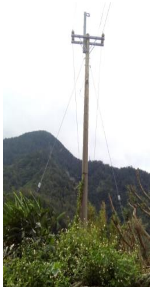
電桿利用 支線 抗拉補強
