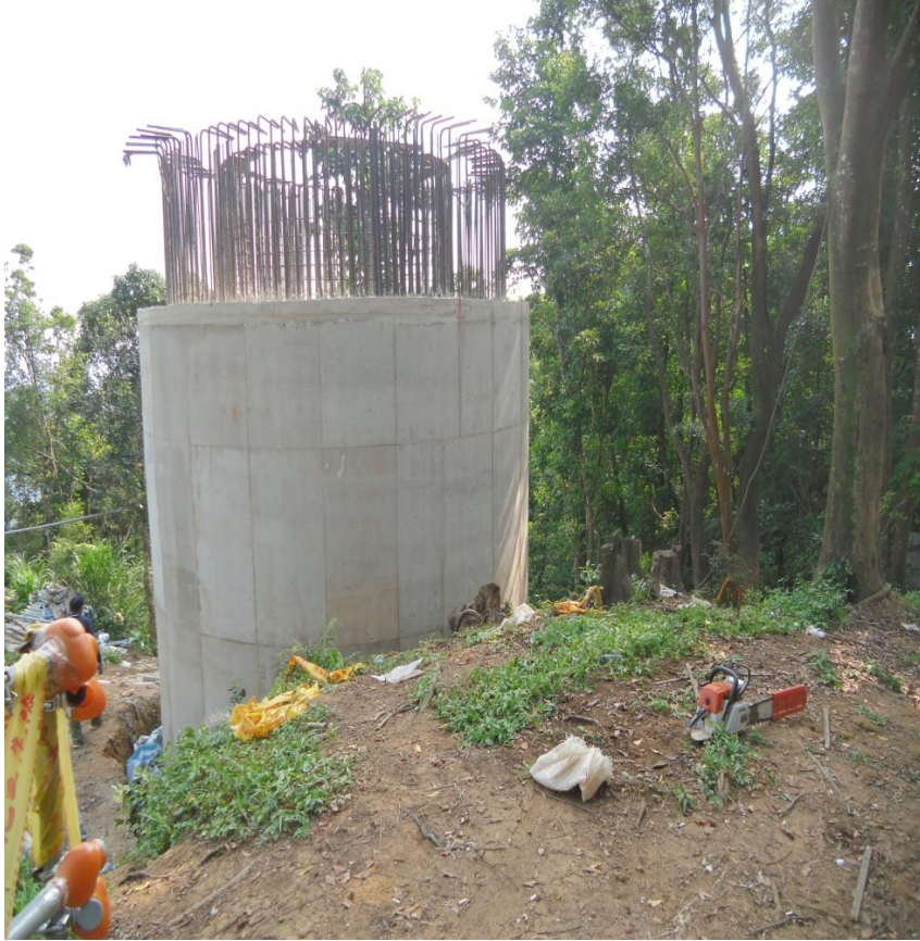
大口徑深基樁 ( 外徑 5 m、環寬 1 m )
