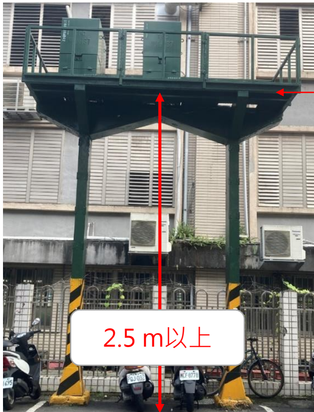
站台式構架 平台底面 離地高度
