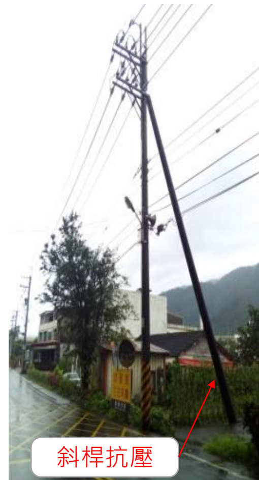
電桿利用 斜桿 抗壓補強
