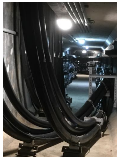
電纜從道路進入地下共同管道
