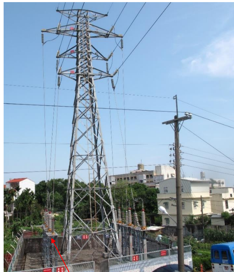
地下電力電纜頭 壓接端子
