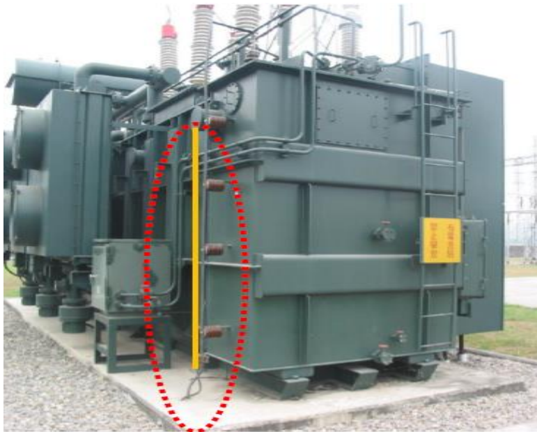
主變壓器中性點直接接地
