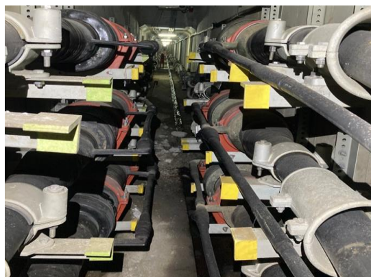
機具暴露可動組件淨工作空間不小於600mm
