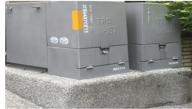
設備固定在基礎台
