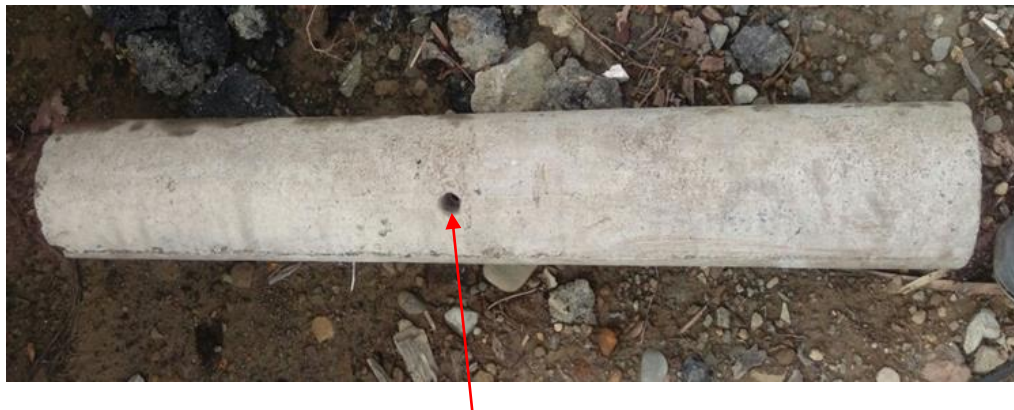
地支線鐵栓穿孔處
