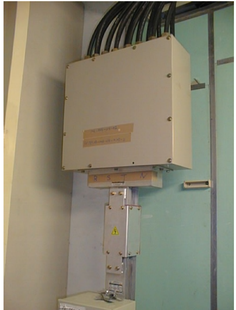
匯流排槽裝設插入式分接器
