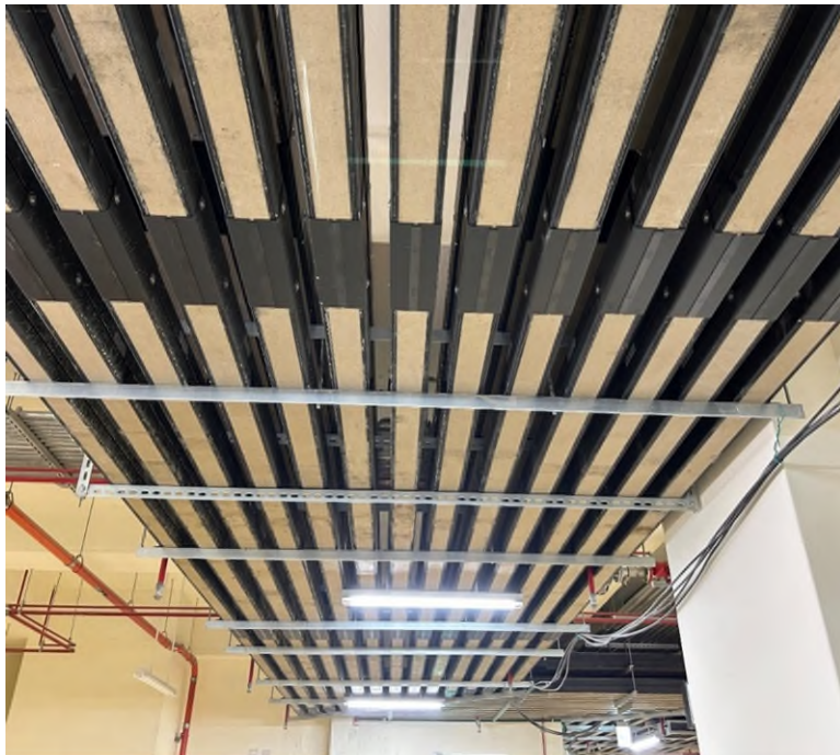
樹脂模注匯流排槽之固定及支撐
