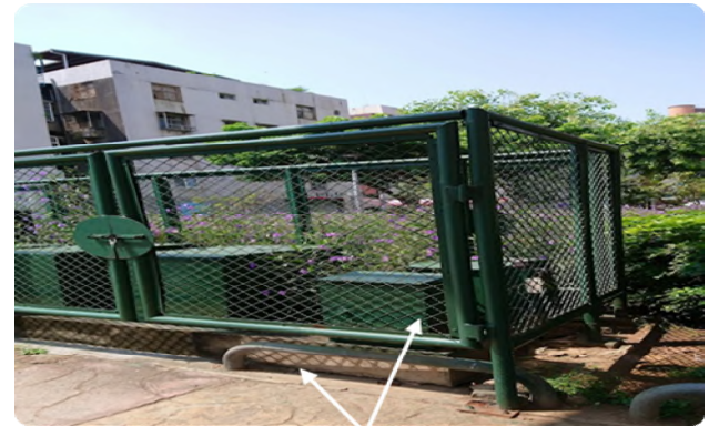
防護裝置 (圍籬、車擋欄杆)
