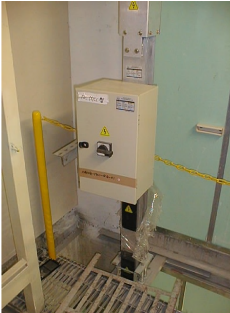
匯流排槽裝設插入式分接器
