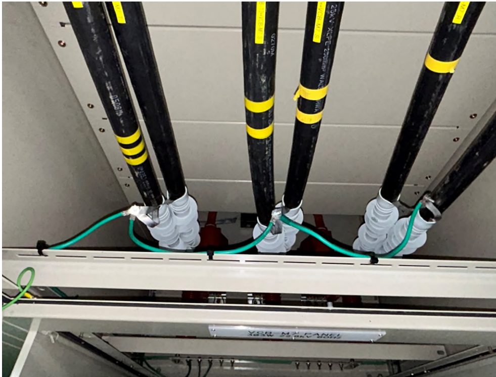
金屬遮蔽層連接於設備接地導線
