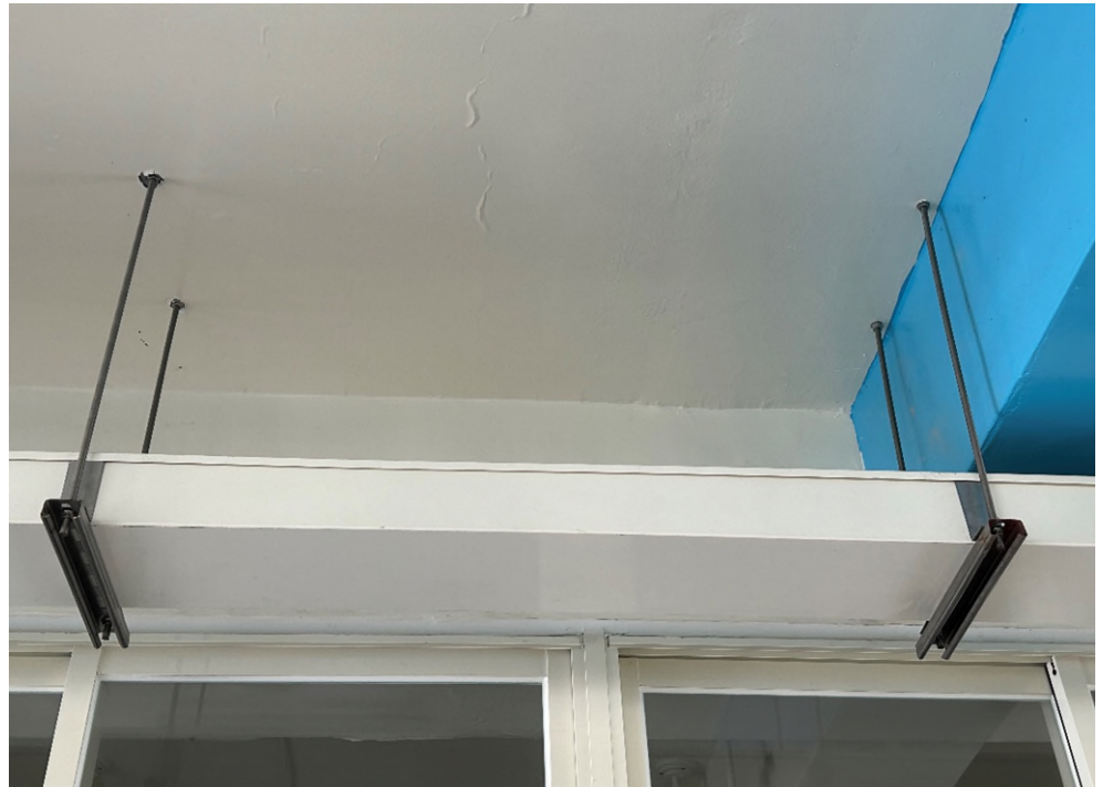
金屬導線槽之支撐距離
