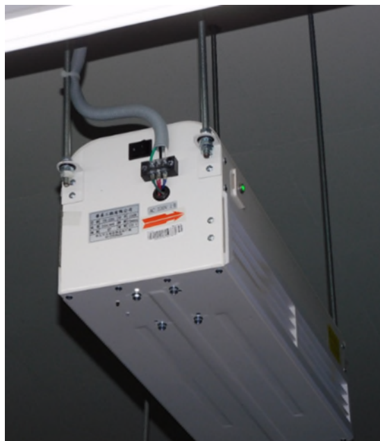
解說圖212：地下停車場導流風機
